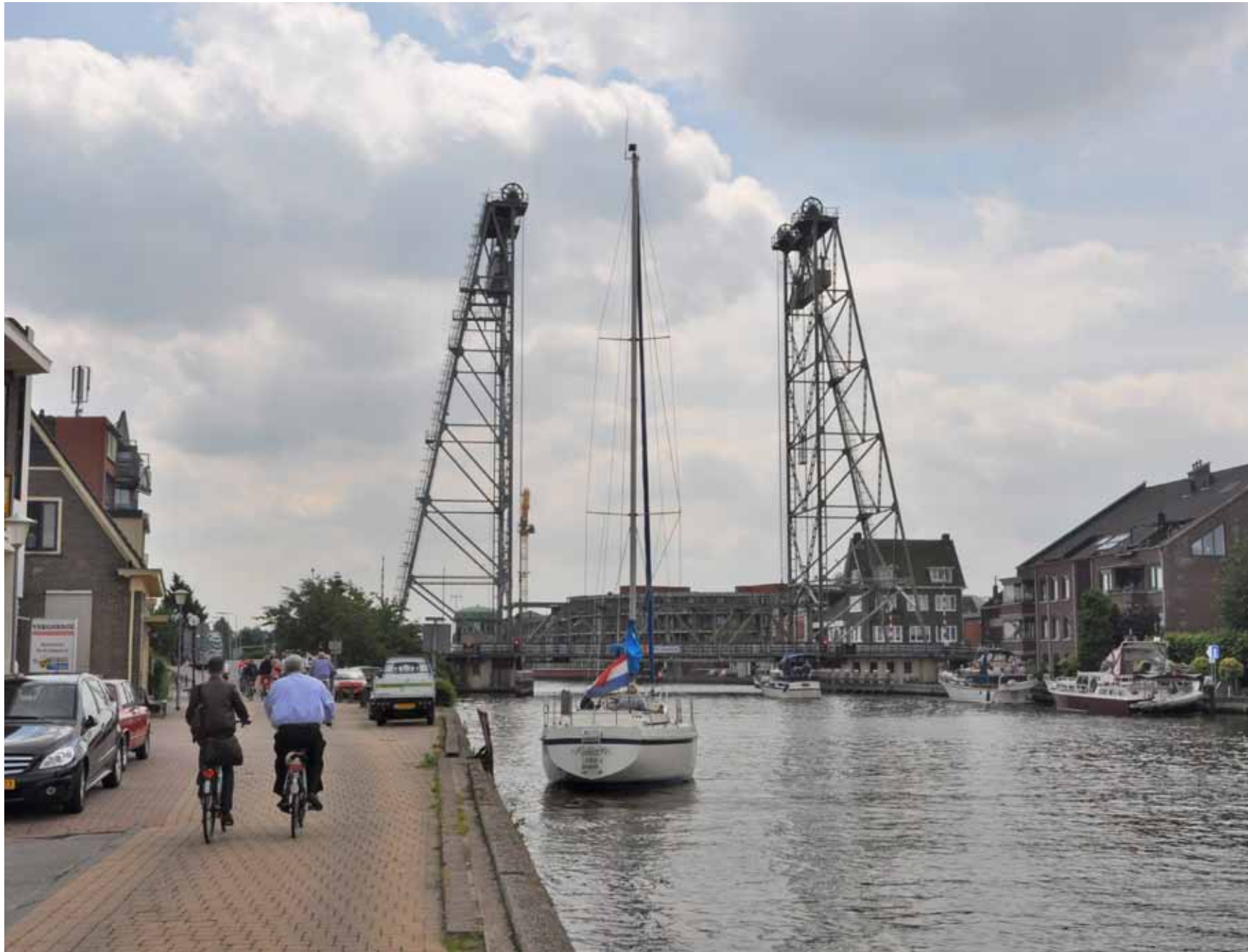
De monumentale hefbrug over de Gouwe, Boskoop
