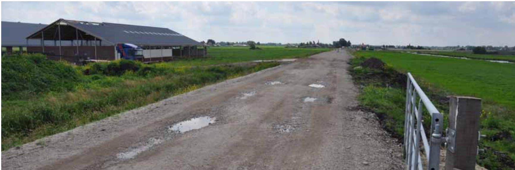
Cunet nieuwe oostelijke rondweg
