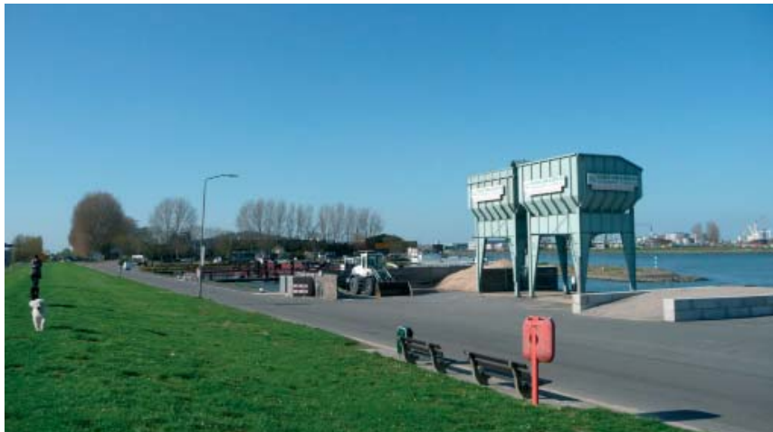
De haven van 's Gravendeel
