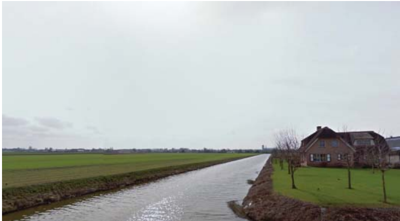
Kanaal tussen de Devel en de Oude Maas
