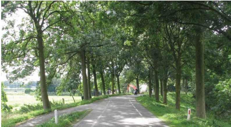
Weg op de kruin van de dijk, beplant
