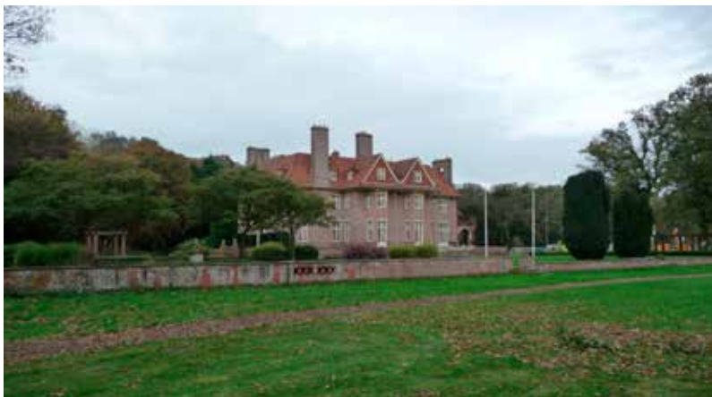
Op Landgoed Voorlinden wordt op dit moment een museum gebouwd
