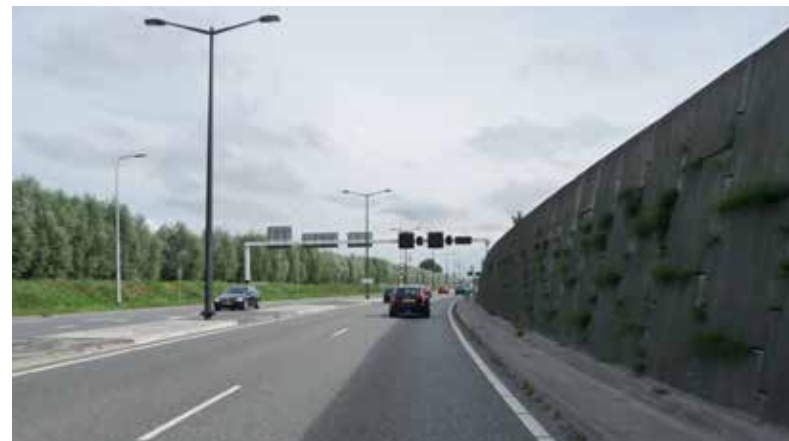
Bij de N14 overheerst het verkeerskundige karakter
