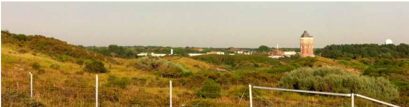
De watertoren van het pompstation Scheveningen
