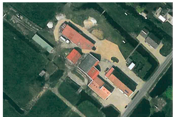
De bestaande boerderij, waarvan de stallen gesloopt zullen worden.
