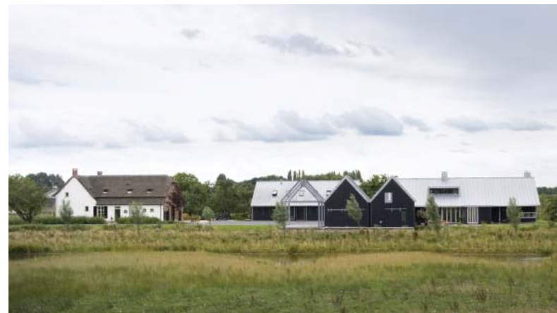
Het getransformeerde erf 'Huis Te Wiel' door NEXT architecten (foto Lisette van de Pavoordt)
