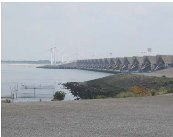
Robuust en technisch karakter van de Haringvlietsluizen
