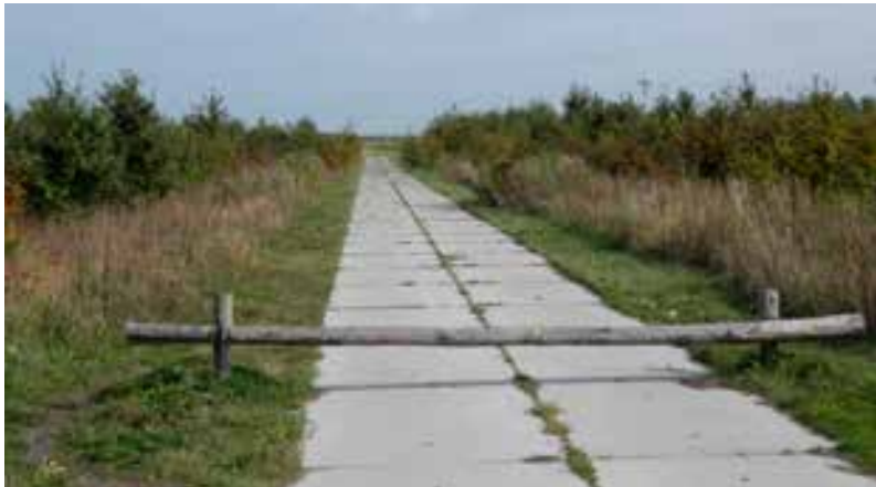
Het Bentwoud in aanleg
