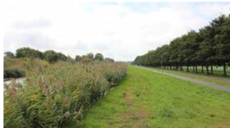
Dijk tussen Tweemanspolder en Eendragtspolder
