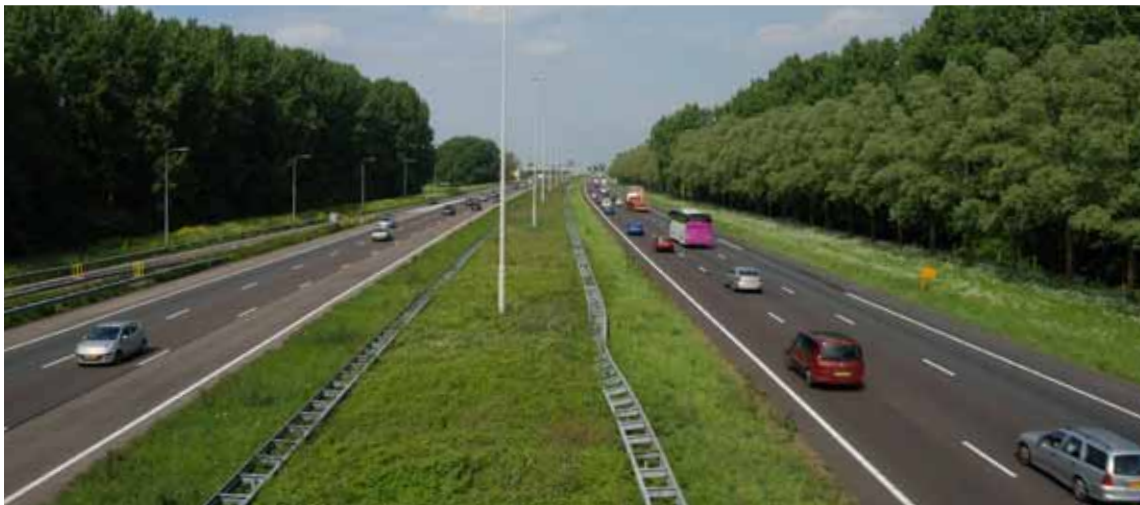
Vanaf de brug over de A16 richting de stad
