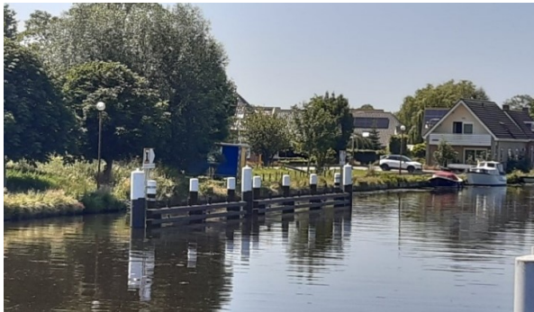
Figuur 4 – Gerealiseerde combi-wachtplaats westzijde langs zuidelijke oever
