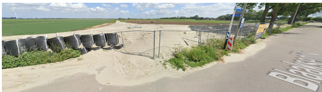
Werken aanleg nieuwe ontsluiting bedrijventerrein, doortrekking Polderweg vanaf N217 naar Weverseinde Puttershoek, (foto: google maps 2022)
