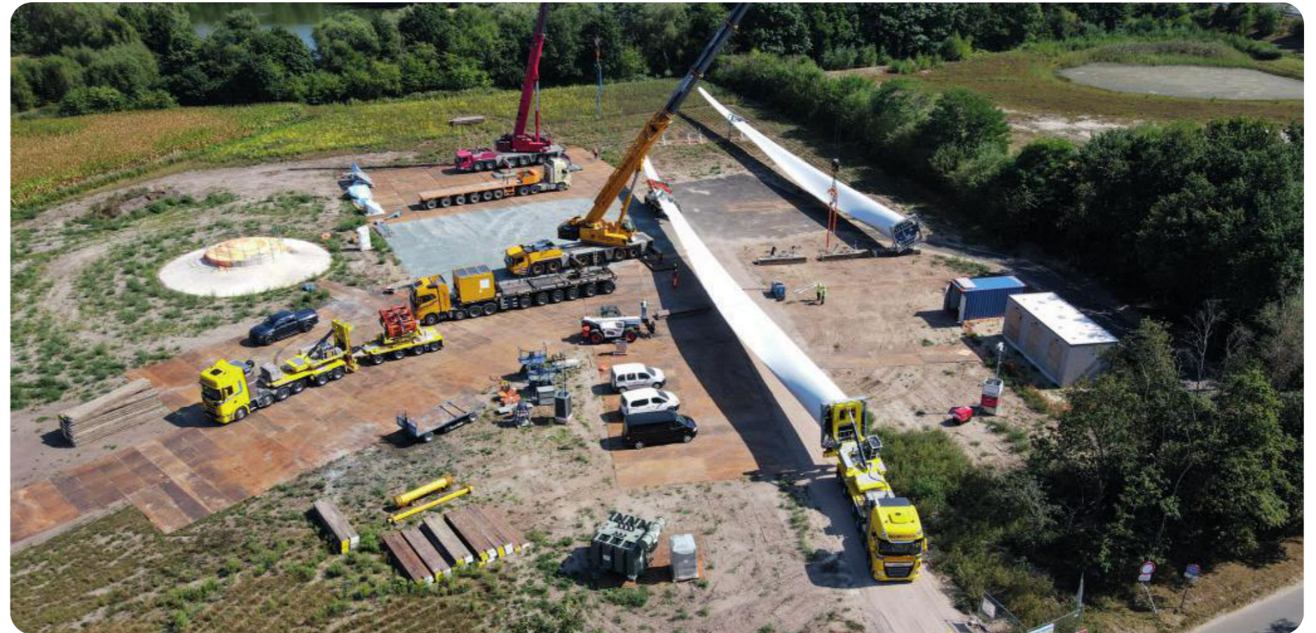
Constructiefase van een windturbine met een tiphoogte van 209 meter, een ashoogte van 135 en een rotordiameter van 149 m. Bron: Windpark Zonzeel, Noord-Brabant, (2023).
