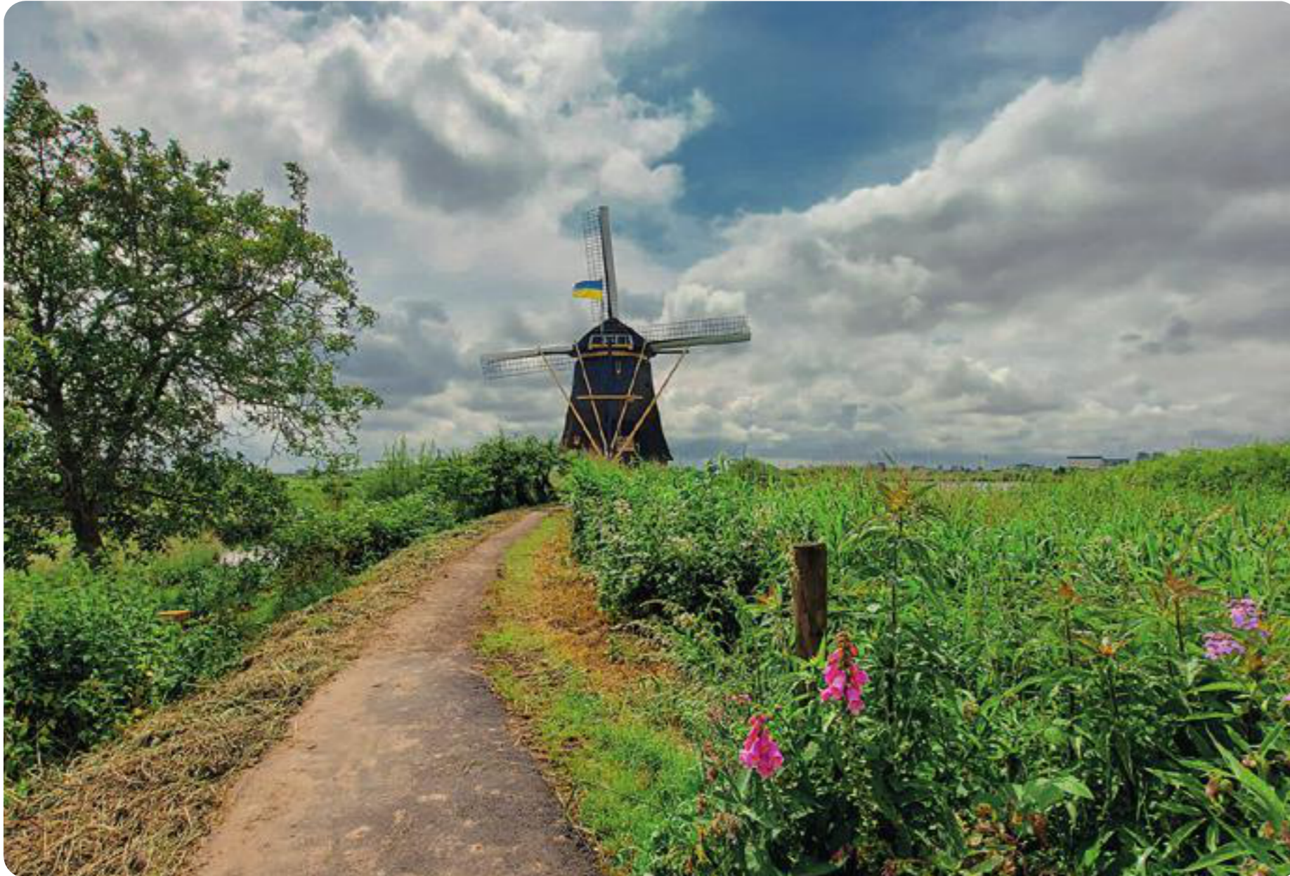
Hoge molen van Nieuw-Lekkerland, de hoge molen pompte het water van de lage naar de hoge boezem van Nieuw-Lekkerland.
