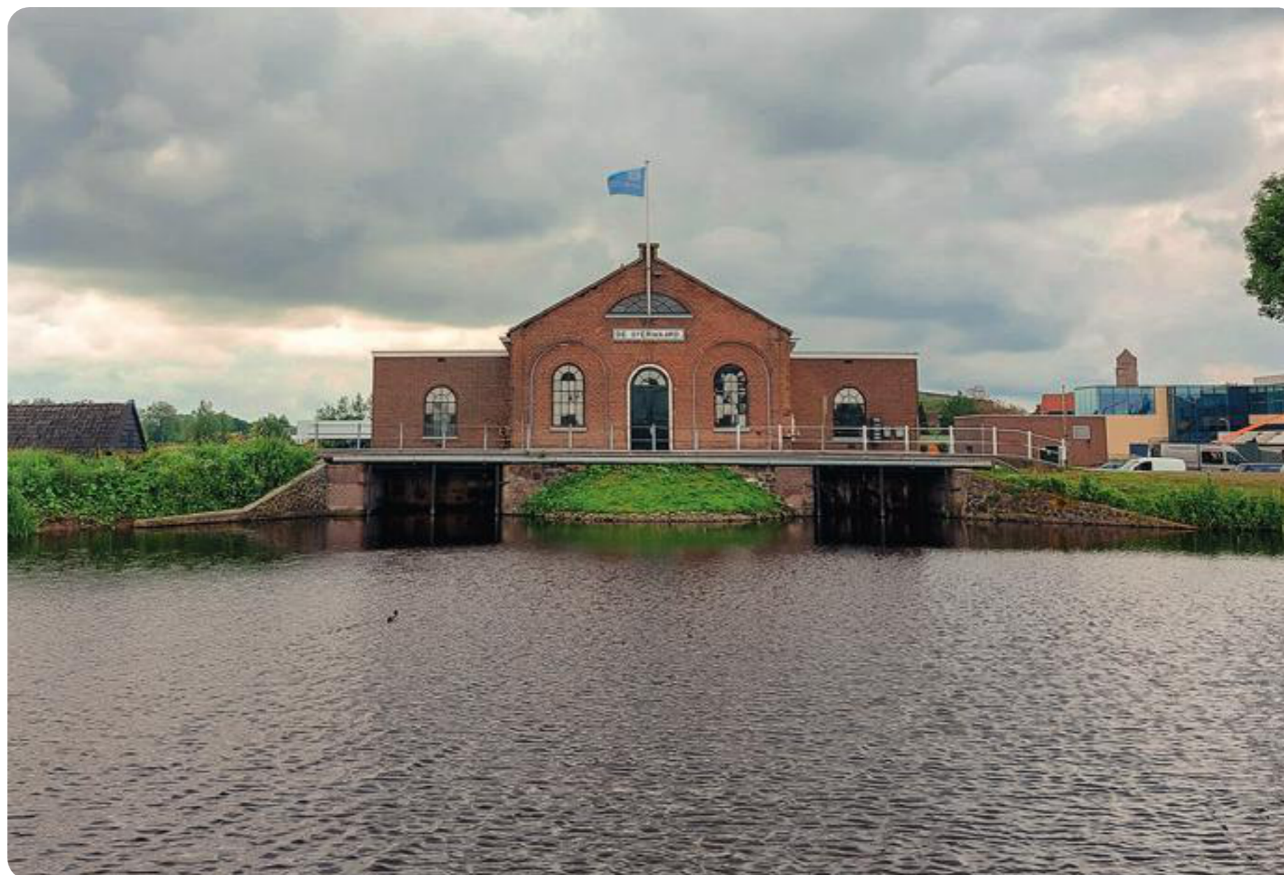
Het Wisboomgemaal aan het noordelijke einde van de Molenkade Overwaard, tegenover het Visitor center.
