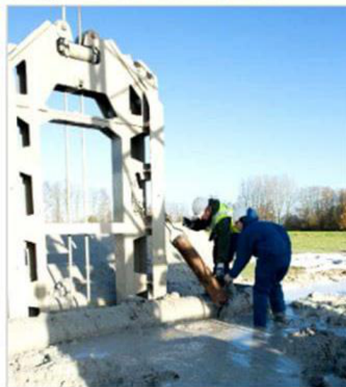
Bevestigen monsterbus cement-bentonietwand
