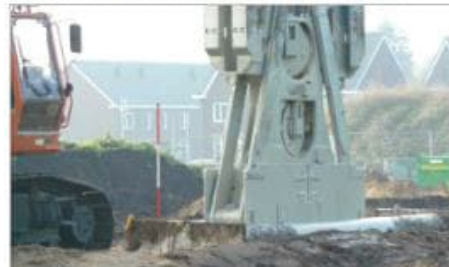
Detail graven cement-bentonietwand, 's-Gravenmoer
