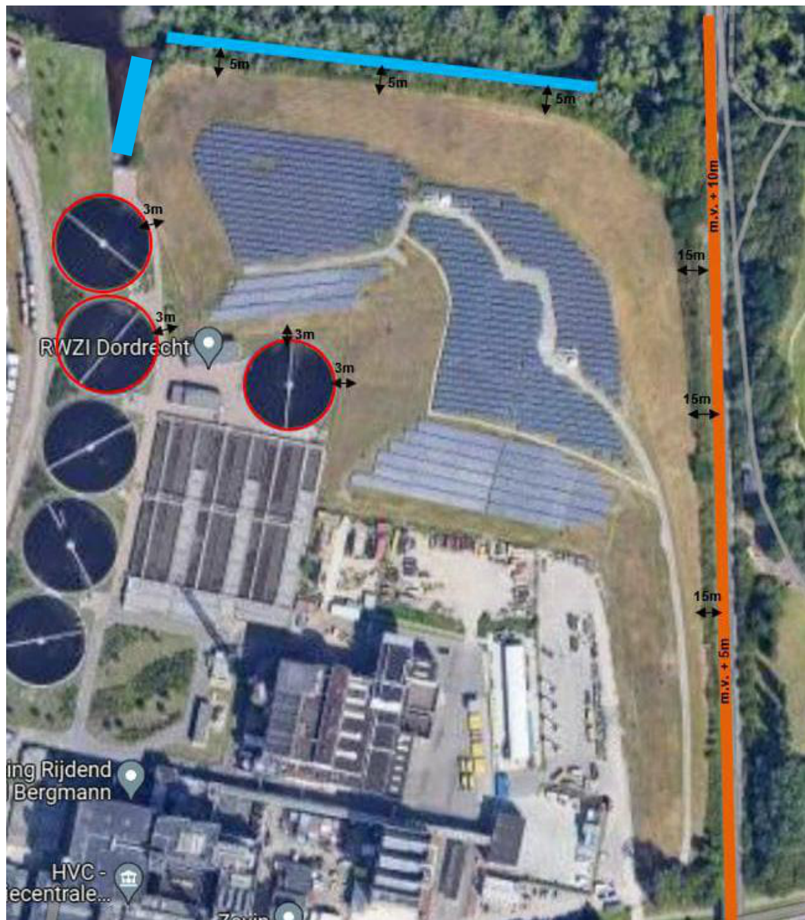
Fig 5; overzicht stortplaats met belendingen
