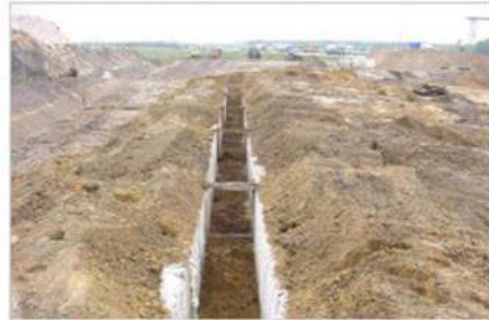
Geleidebalken cement-bentonietwand
