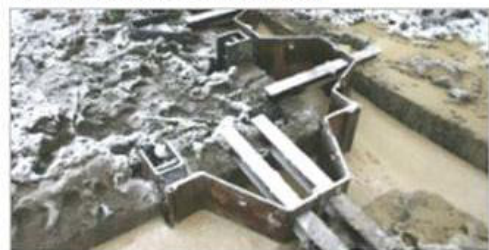
Cement-bentonietwand met damwand
