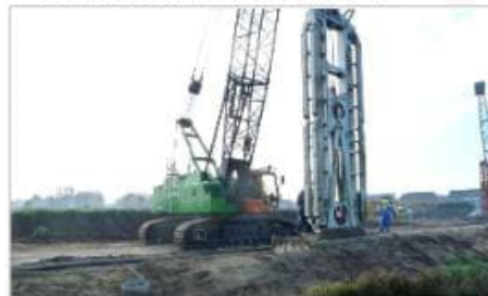
Detail graven cement-bentonietwand, 's-Gravenmoer
