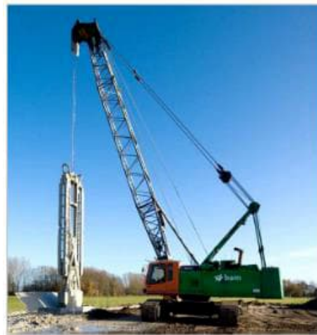
Graven cement-bentonietwand, 's-Gravenmoer
