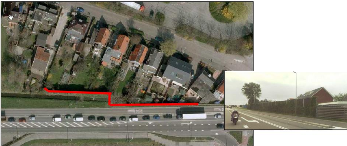
Figuur 3.1: Aanwezig scherm langs de Burgemeester van Doornlaan ter hoogte van woningen Leeweg art 5 1-2e
