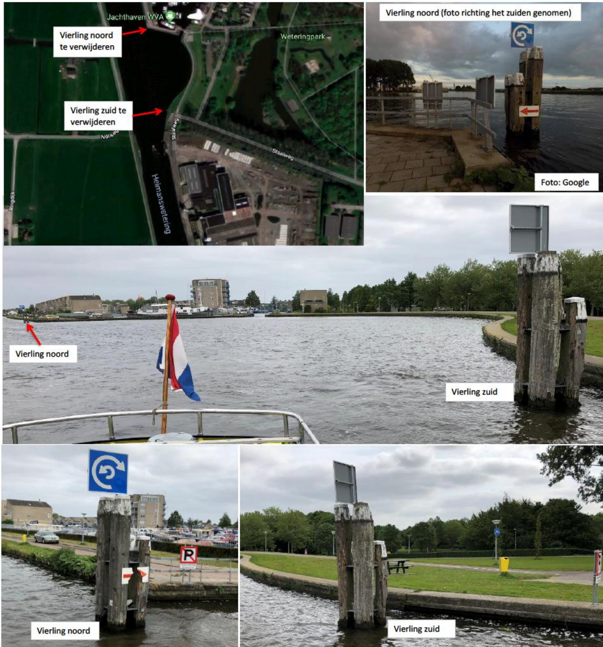
Figuur 4-4: Locatie ten noorden van de klepstuw van het Hoogheemraadschap van Rijnland nabij de kom naar de ingang van de jachthaven
