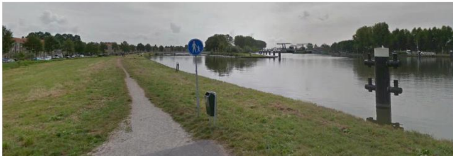
Figuur 4-17: Bestaande situatie nieuwe ligplaats locatie 9
