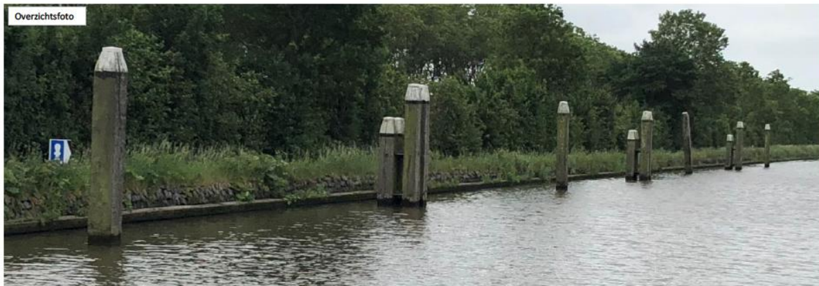
Figuur 4-8: Overzicht van de wachtplaats op locatie 5
