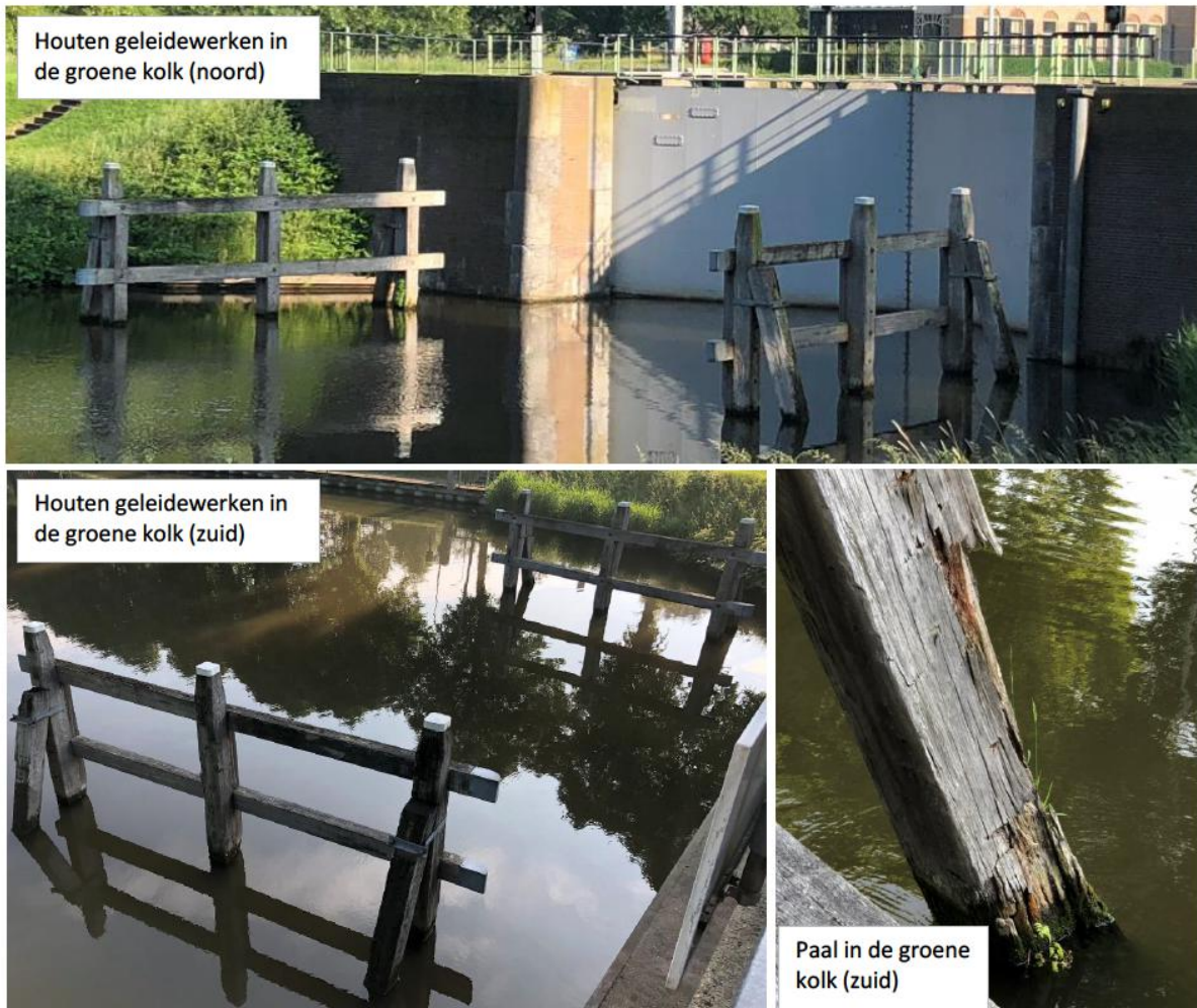
Figuur 4-244: Bestaand remmingwerk
