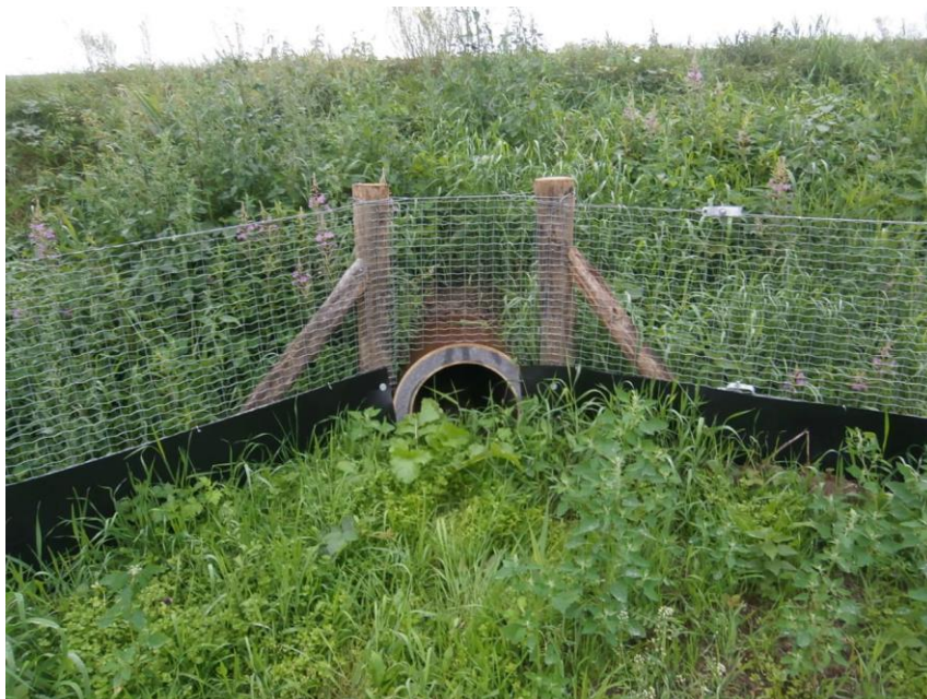
Figuur 2: Voorbeeld tunnel voor klein wild
