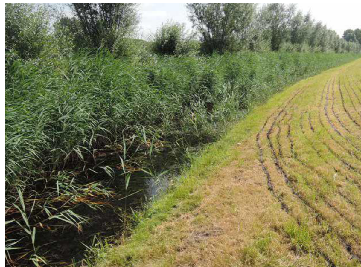
afb. 19: Kavelsloot langs de Landscheiding met riet en knotwilgen die verbreed zal worden met een plasberm (haverdroeze.nl)
