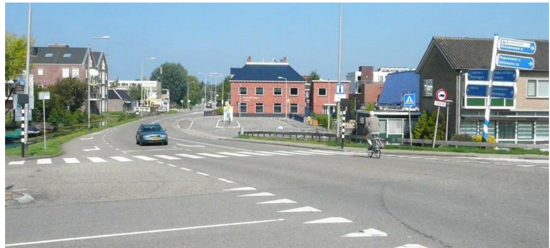
Kruising aan overzijde van het kanaal heeft door de vormgeving weinig samenhang met de rotonde. Ook is hier een overdaad aan asfalt.
