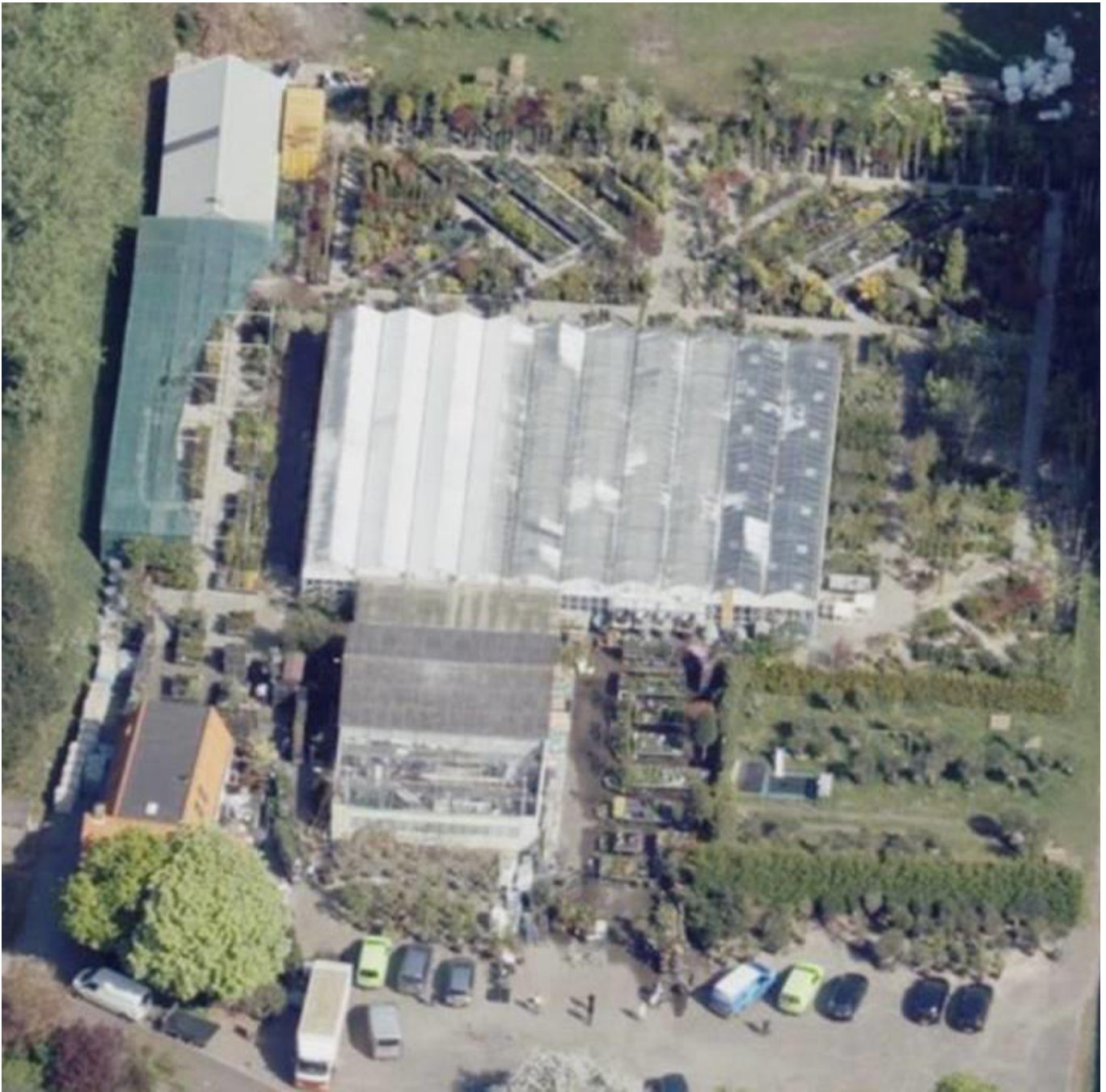
Foto van het perceel met aan de voorzijde parkeren en opslag en een gedateerde schuur links. Dit voorste gebied wordt dus geheel opengemaakt en opnieuw ingericht. art10 2c art10 2c waar ook de groenbuffer wordt beoogd.
