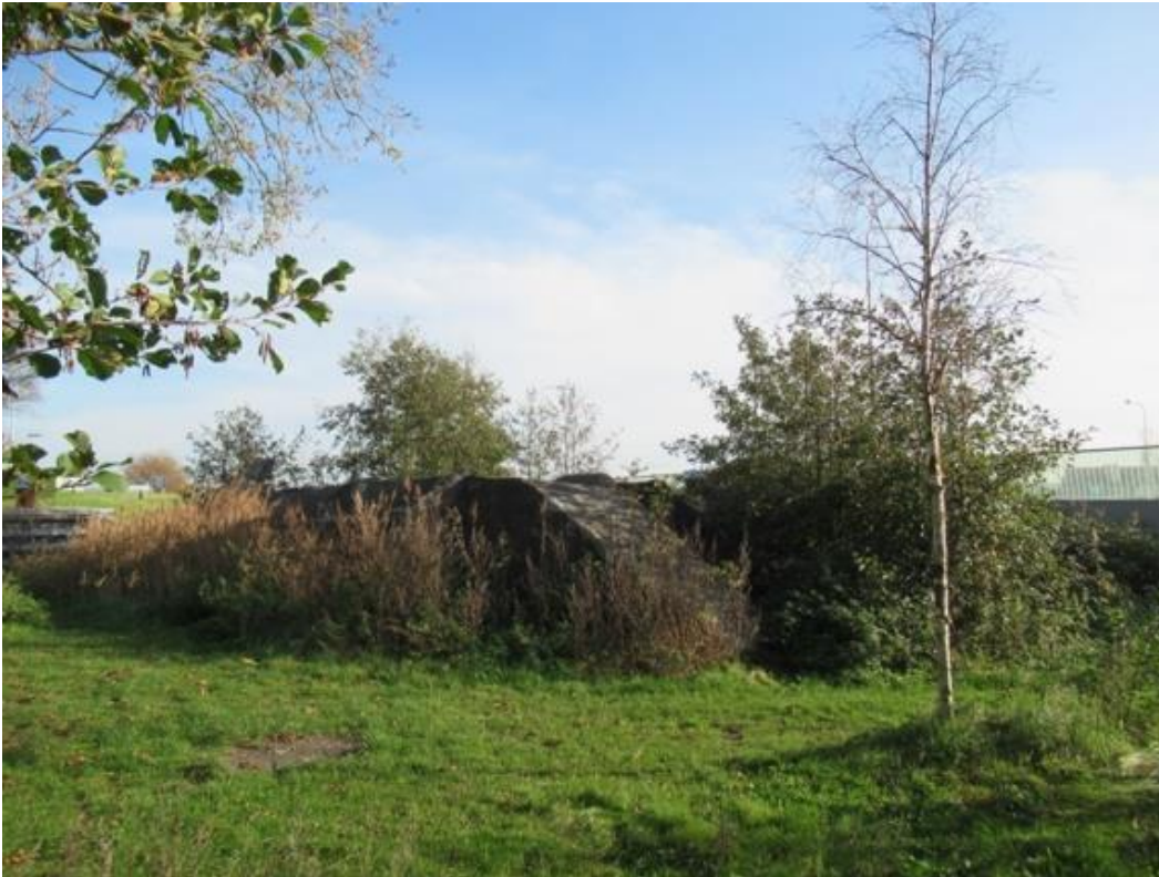
Dit is WN 33 – ontoegankelijke scheefgezakte bunker
