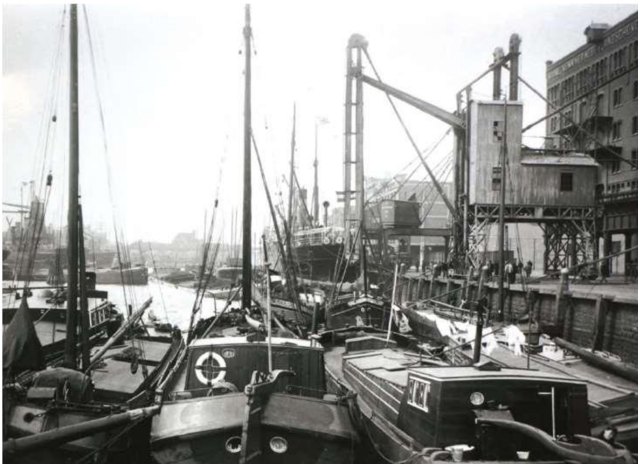
Figuur 5 Rijnhaven oostzijde met rechts veemgebouw de Eersteling, 1910 (uit: van Winsen et al., 2018)
