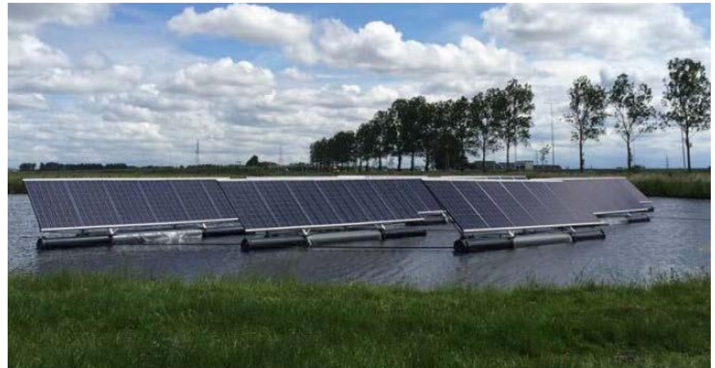
Drijvende zonnepanelen (Rijkswaterstaat, Slufter)
