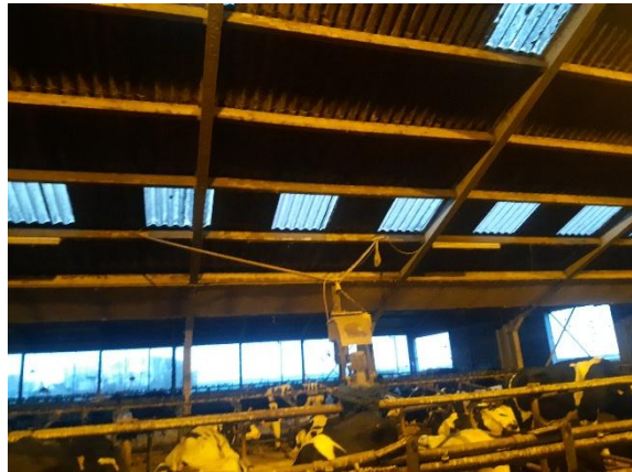
Verbinding tussen voerboxen en staalconstructie stal
