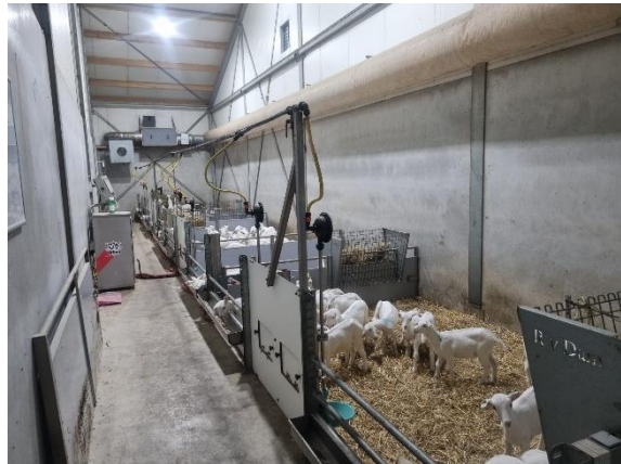
De metalen constructies van hekwerken van jongveestal afdeling 2 zijn onderling doorverbonden.
