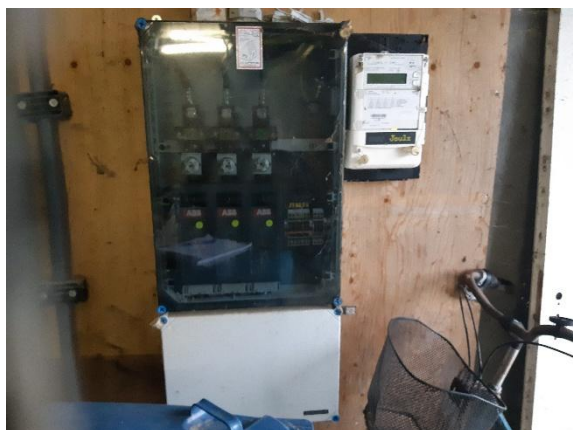
Aansluitkast Stedin
