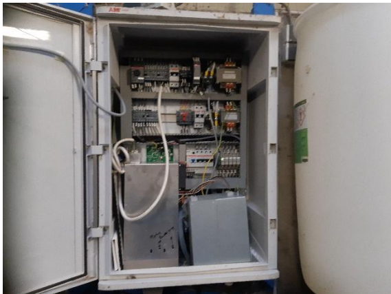
1 Besturingskast carrousel
