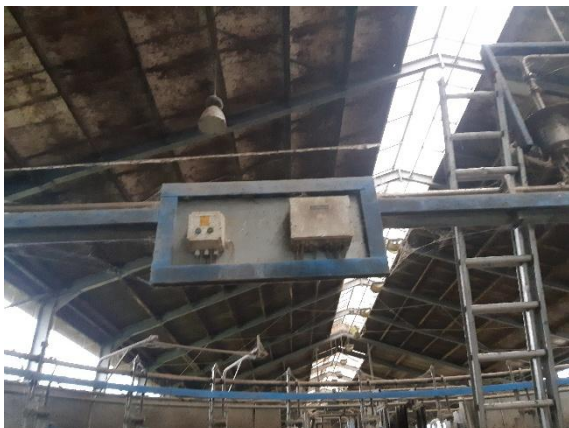
3 Rechtboven de draaikop met glijcontacten
