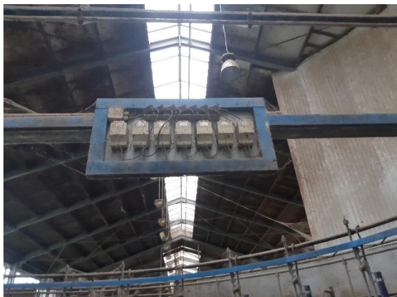
4 Voeding met transformatoren
