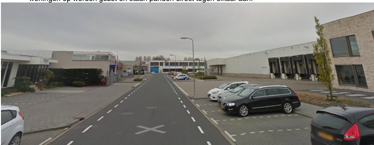
Afbeelding 3 Bedrijventerreinen typeren zich door inefficiënt ruimte gebruik: hoofdzakelijk 1-laags bouw en veel parkeerterruimte.
