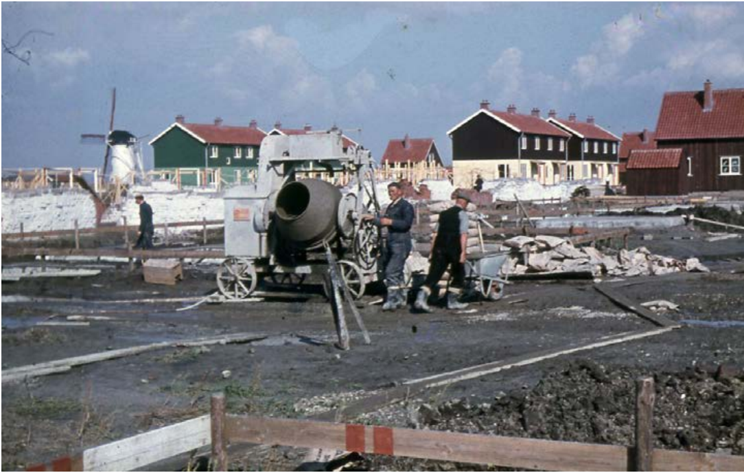
Woningen in aanbouw in Nieuwerkerk, Schouwen-Duiveland
