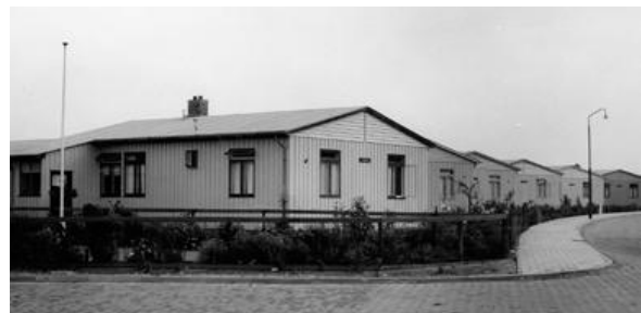
Ensemble woningen aan de Noorsestraat in Ouwerkerk, kort na oplevering
