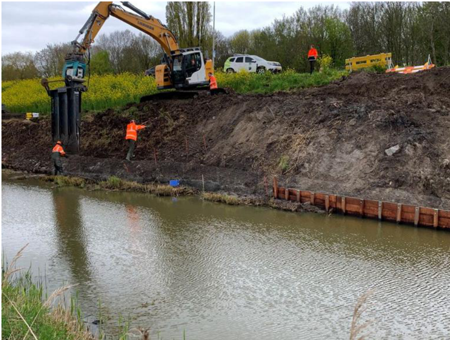
Afbeelding 4.2: het drukken van gaas in een waterkering - met daarboven een weg - waarin bevers holen hadden gegraven in Numansdorp.
