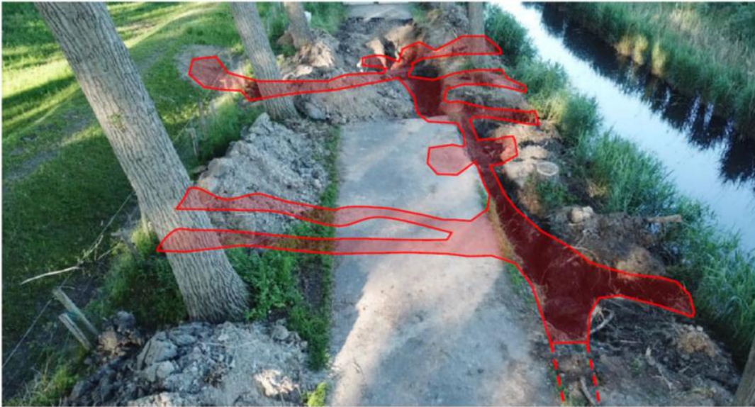
Afbeelding 4.3: Contouren van beverholen (in rood) onder ongeveer 15 strekkende meter van de Van Pallandtweg bij Middelharnis, begin juni 2021.
