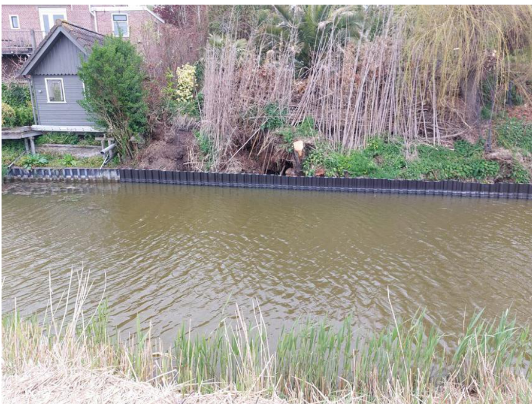
Afbeelding 5.2: Geplaatste damwand in Numansdorp
