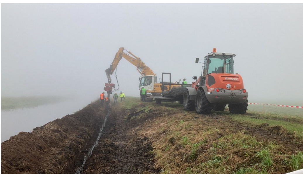
Afbeelding 5.3: Het plaatsen van gaasmatten langs de Hunze in Drenthe
