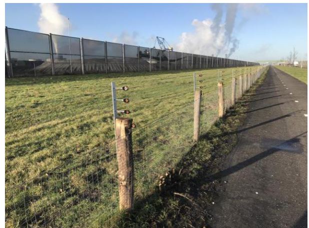
Afbeelding 22: geplaatste stroomdraden langs de Markweg, havengebied Rotterdam
