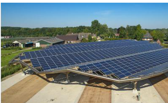
Figuur 11. Parkeervoorziening / laadplein
