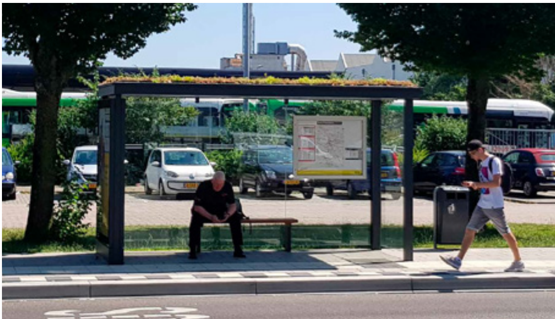
Sedumdak op abri
