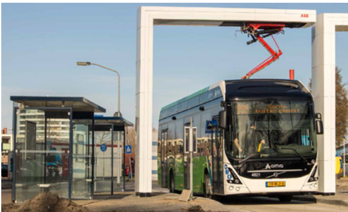
Oplaadpunt elektrische bus bij station De Vink
