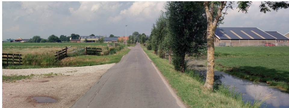
Figuur 28: Het huidige Rietveldsepad ter plaatse van de kruising met W20-3
