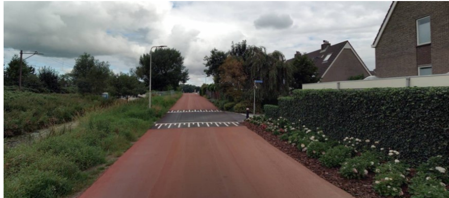
Figuur 40: Bestaande situatie van Paddegat tussen Laag Boskoop en De Oude Wijk
