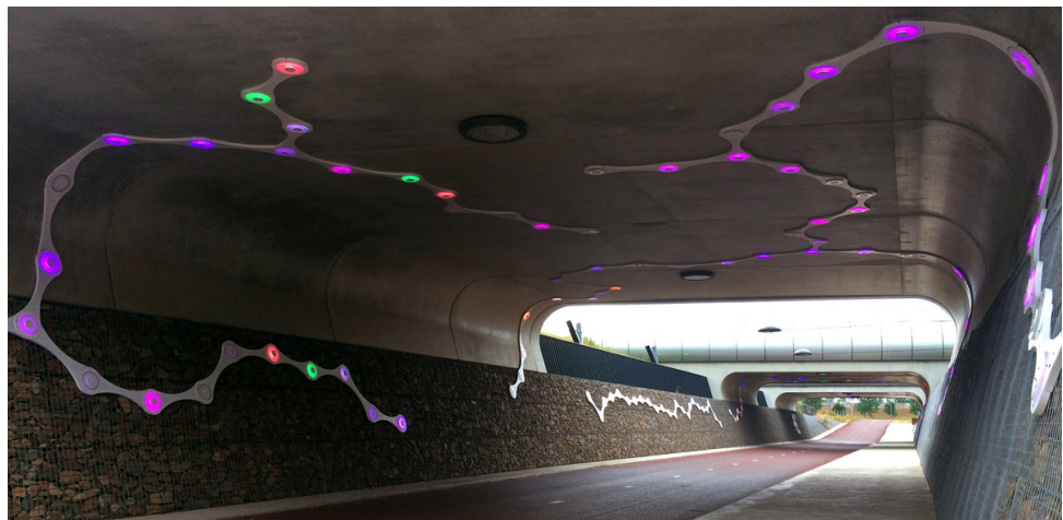
Figuur 4.14: Verlichte onderdoorgang RijnWaalpad
