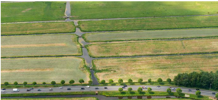
↑ LUCHTFOTO HUIDIGE SITUATIE VAN DE EUROPAWEG.
