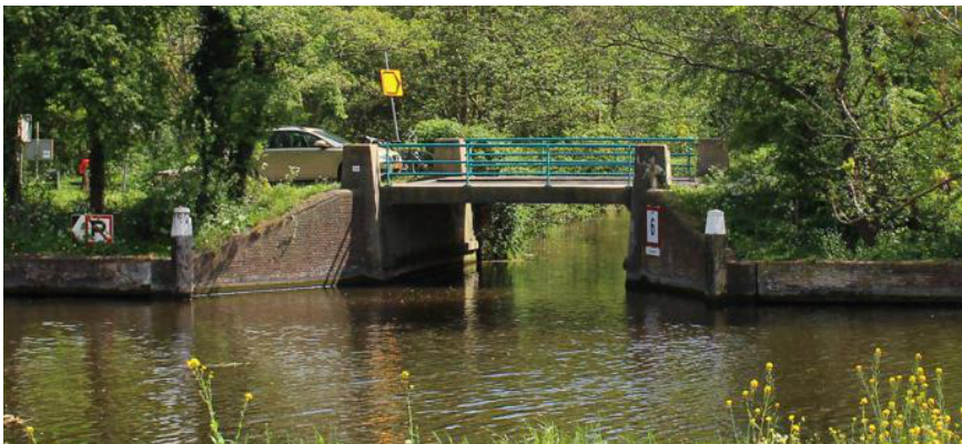
↑ HUIDIGE KNOTTERPOLDERBRUG ALS REFERENTIE VOOR DE NIEUW AAN TE LEGGEN BRUG, EIS 3.6.7.2.
