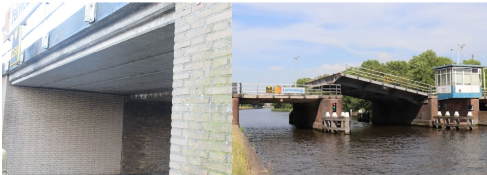
Figuur 1.3. Links: Trekvliefbrug met losse betonplaten.
