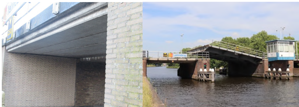
Figuur 4.2. Links: Trekvlietbrug met losse betonplaten. Rechts: Lammebrug met mogelijk geschikte locaties voor vleermuizen (foto M. van Beelen juni 2021).
