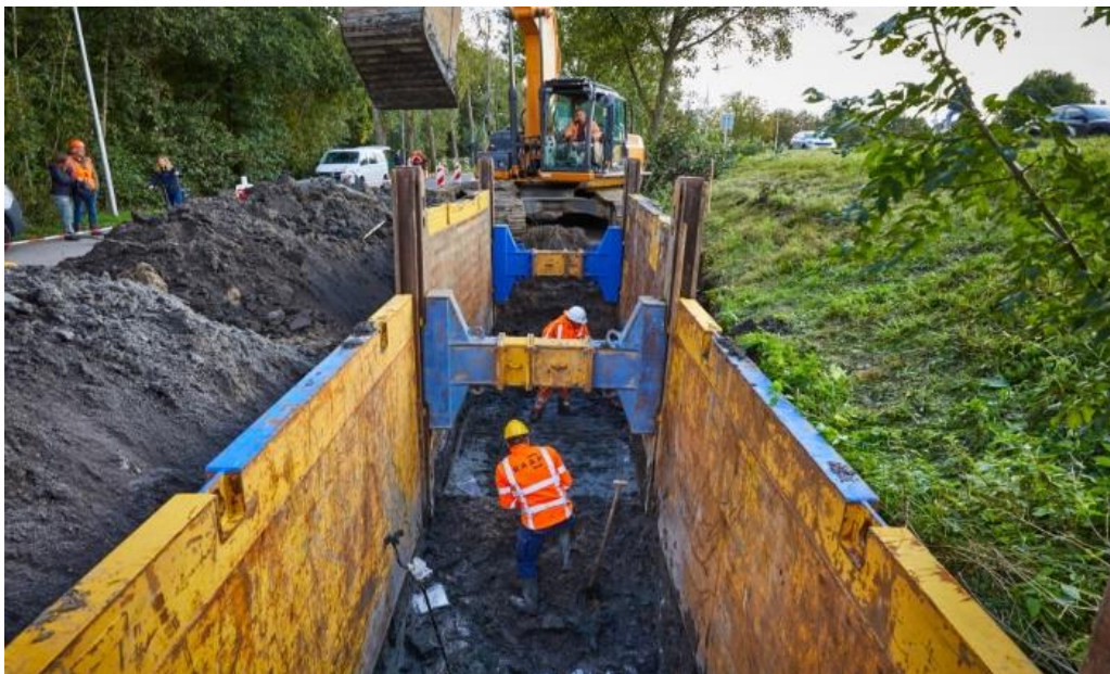
Figuur 12. De sleufbekisting tijdens het aanbrengen ervan (foto V. Basler).
