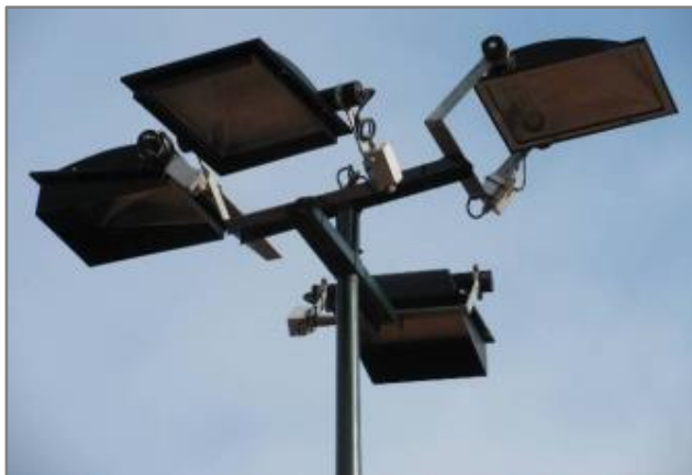
Figuur 7-1: Vleermuisvriendelijke verlichting, gedempt amberkleurig licht, aangepaste armaturen zonder lichtverstrooiing en toepassen op korte palen.
