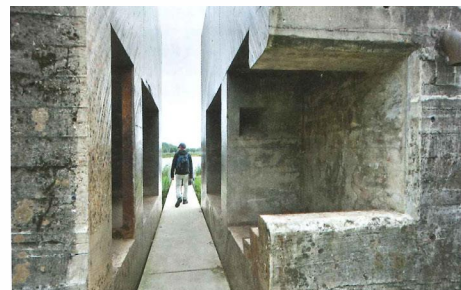
Opengesneden bunker 599 [Blauwe Kamer Jaarboek 2012]
