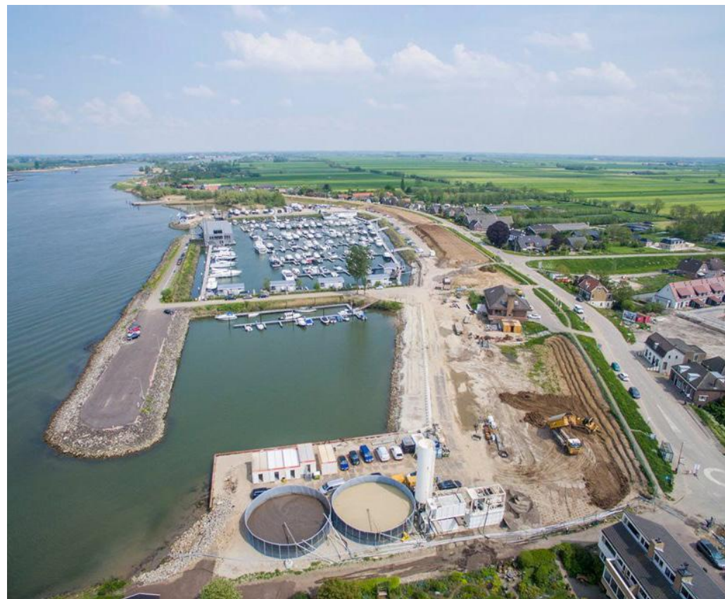
Luchtfoto van realisatie. Bron: Franki Grondtechnieken B.V.
