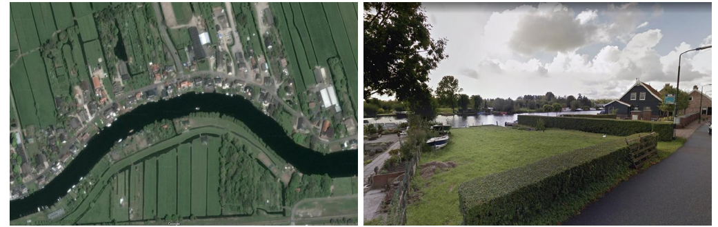
Dijk aan veenstroom bij Giessendam De dijk loopt parallel aan de veenstroom. Aan beide zijden van de dijk bevindt zich bebouwing. Het voorland voor de dijk ligt hoger dan het omliggende land. De dijk is laag en ligt verweven in het landschap.
