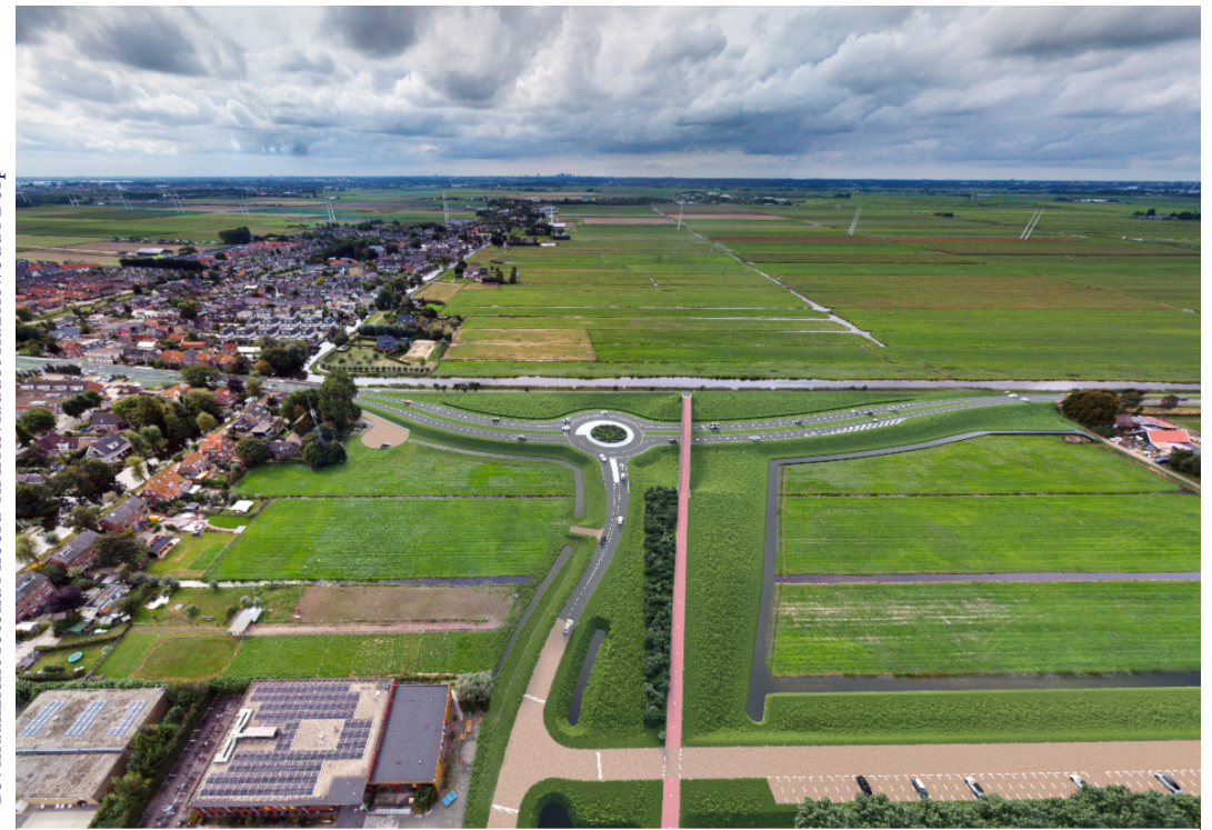
Bovenaanzicht rotonde noord en fietsviaduct Hazerswoude-Dorp
