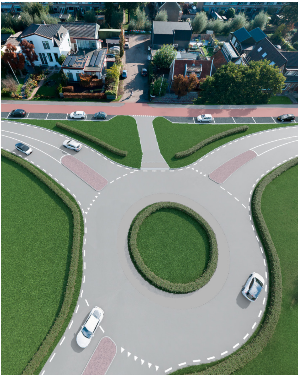
Rotonde aan het einde van de Verlengde Beethovenlaan
