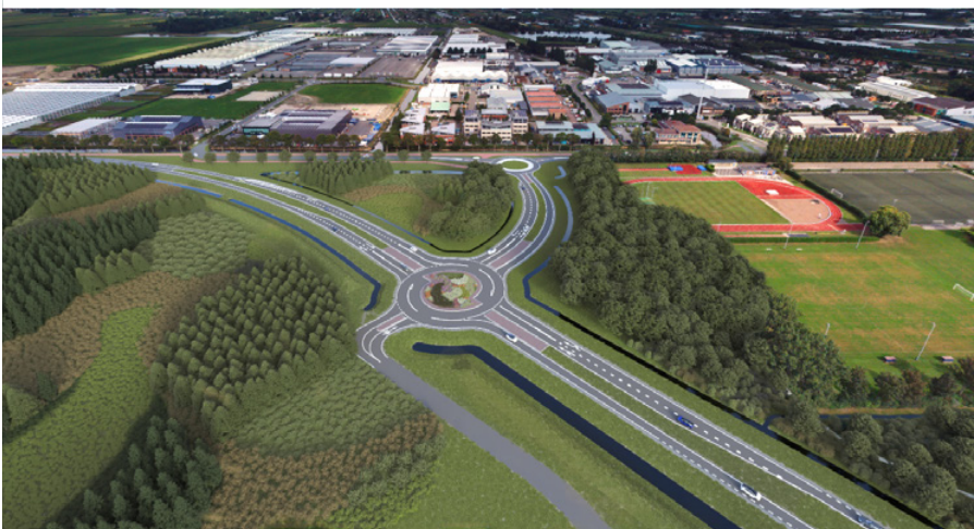
Rotondes sluiten aan op de Hoogeveenseweg
