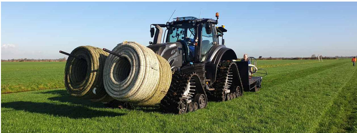
De aanleg van waterinfiltratie
