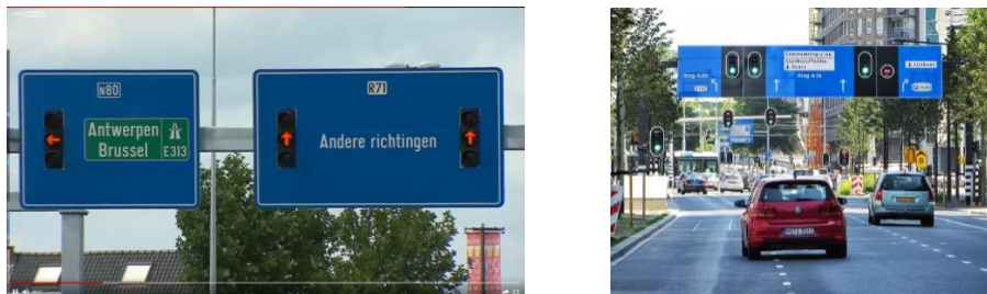
Figuur 4: Geïntegreerde verkeerslantaarns in bewegwijzeringsborden in Hasselt (links) en Rotterdam (rechts)
