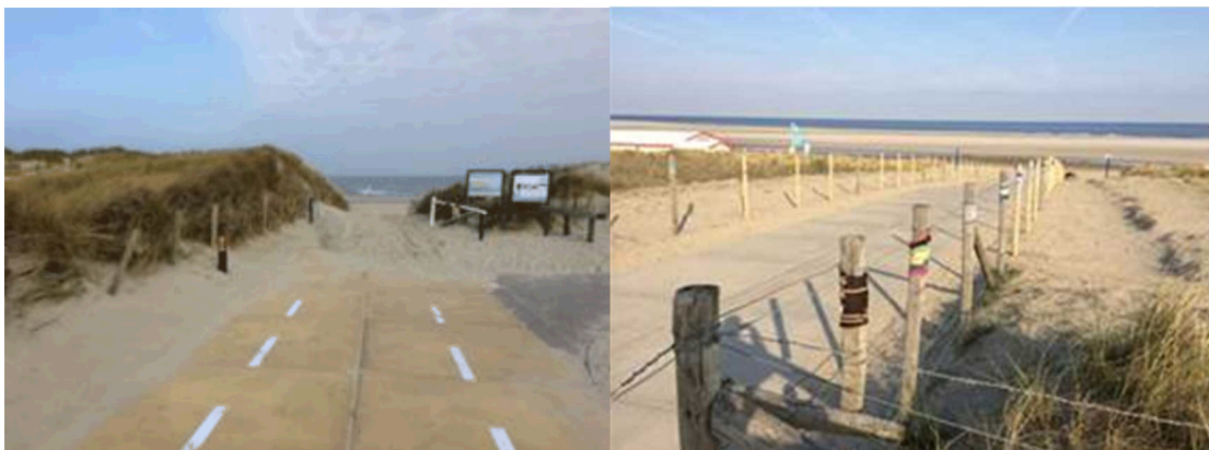
Figuur 8.2 Links: ondergestoven strandslag. Rechts: schoongemaakte strandslag waarbij ook het raster is vrijgemaakt
