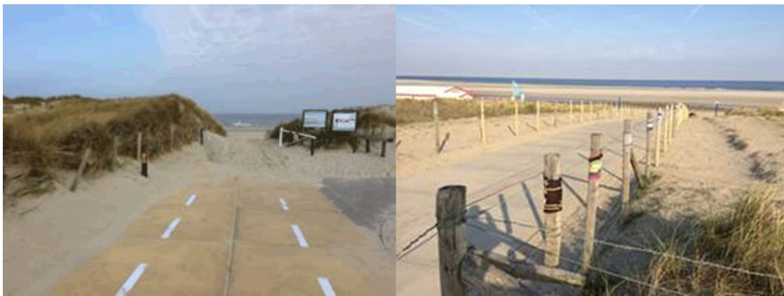
Figuur 8.2 links: ondergestoven strandslag. rechts: schoongemaakte strandslag waarbij ook het raster is vrijgemaakt
