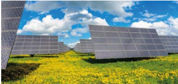
Tijdelijke energieopwekking d.m.v. zonnepanelen (ca. 150 ha.).
