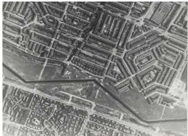
RAF luchtfoto uit '43 van aangelegde tankgracht in Den Haag waarvoor grootschalige sloop heeft plaatsgevonden. (bron: Nationaal Archief)
