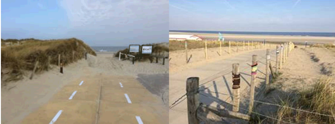
Figuur 8.2 links: ondergestoven strandslag. rechts: schoongemaakte strandslag waarbij ook het raster is vrijgemaakt
