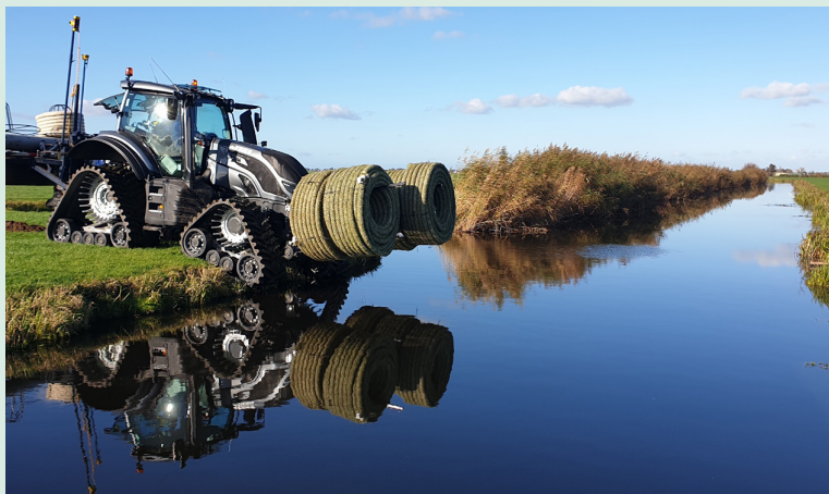
Foto: aanleg onderwaterdrainage
