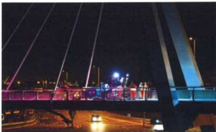
Werkzaamheden om Fietsbrug de Snelbinder in Naaldwijk te voorzien van antivries-asfalt.
