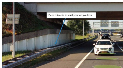
Figuur 8 de ruimte onder het viaduct bij afrit 8
