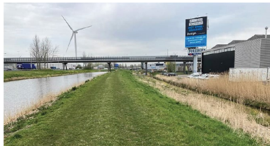
Figuur 6 de waterkering achter de bedrijven
