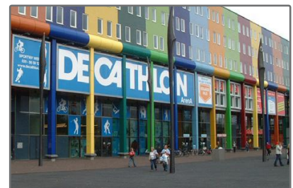
Decathlon op de ArenA Boulevard in Amsterdam
