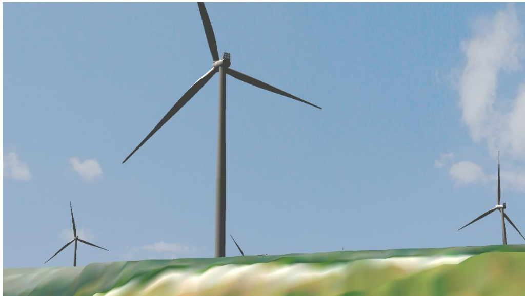
Figuur 21.6 Voorbeeldopstelling onderzoeksgebied #16 – standpunt Kruisweg
